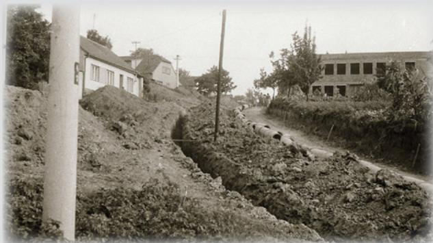
Budování kanalizace od samoobsluhy k obecnímu úřadu, který je na fotografii rozestavěný
