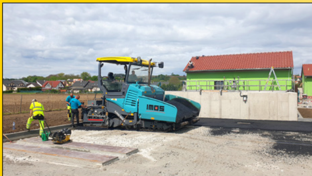
FINÁLNÍ PRÁCE NA ČISTÍRNĚ ODPADNÍCH VOD
