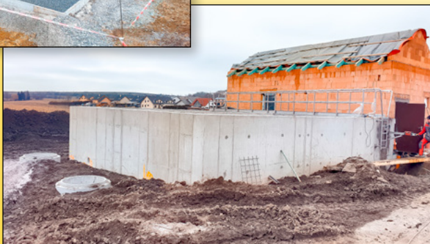
VÝSTAVBA ČISTÍRNY ODPADNÍCH VOD
