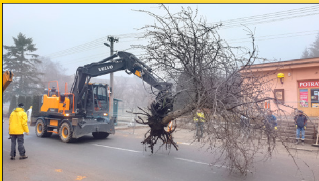
REKONSTRUKCE CHODNÍKU PŘED SAMOOBSLUHOU
